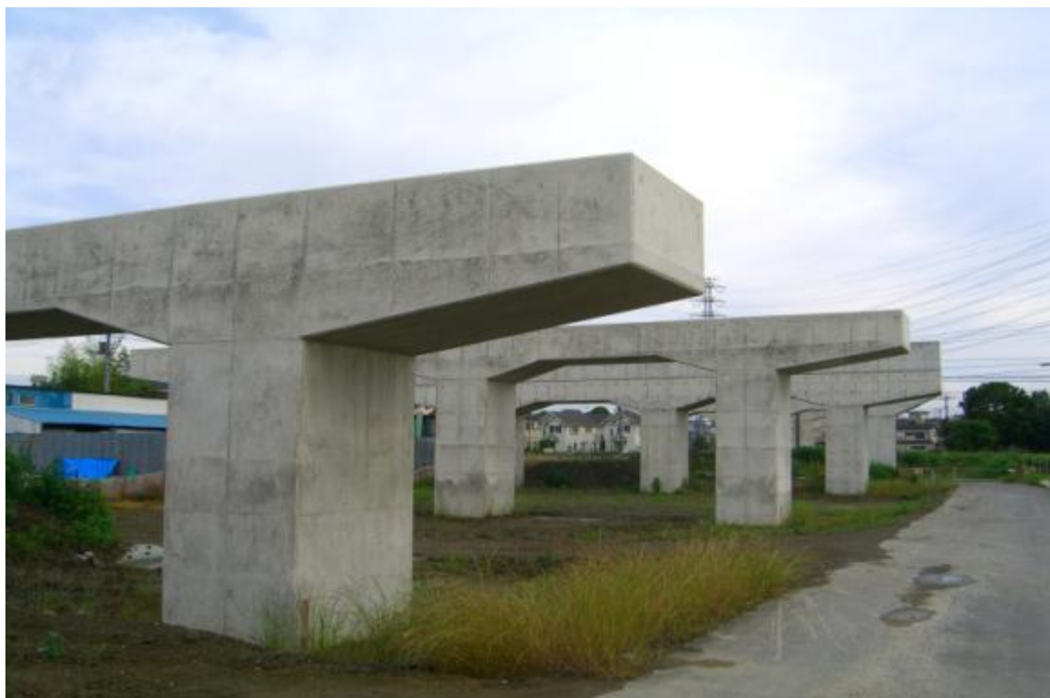
☆北環状線道路の建設状況
