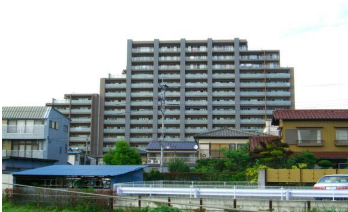
☆ 第三支会東部・田町に立つ高層マンション
